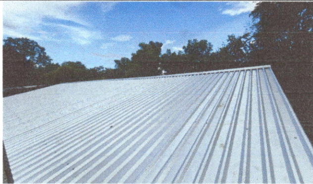
FOTO1: Sustrucción de lámina, por lámina troquelada o acanalada aluzinc calibre 26
